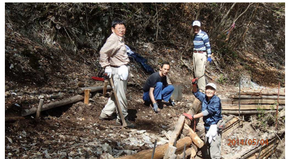
中の峪ガレ場改修作業(54)
