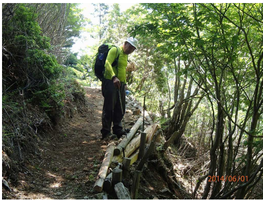
鉄塔下の改修を検分する
