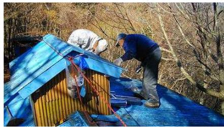
屋根のさび落としと箒で掃き落とし
