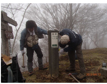
証誠無漏岳で道標設置と傾いた石柱道標復旧 涅槃岳の復旧石柱道標
