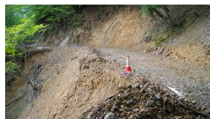
池郷林道の補修状況
