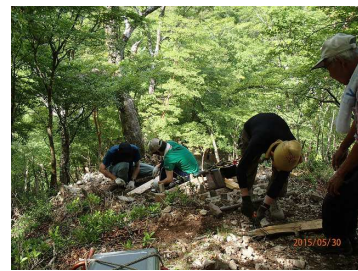
ブナ倒伏跡に段差設置 段差を番線で固定中
