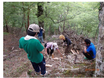
ブナ倒伏跡に段差設置 段差を番線で固定中
