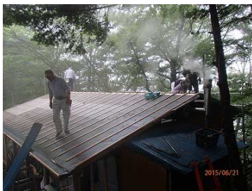
棟トタン被せ中
