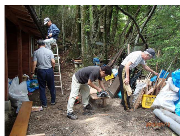
トユカバー取付・板切断
