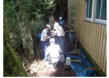
薪小屋東石据付作業
