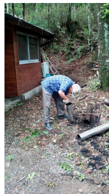
煙突の煤取り
