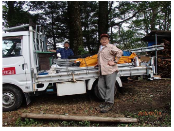
ビケ足場積み込み完了
