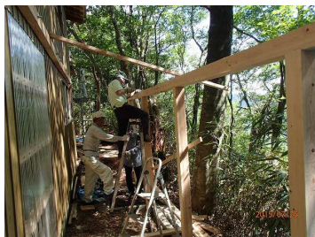
桁に柱据付中
