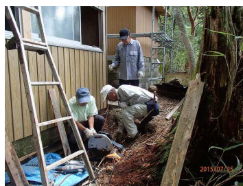
通しボルト切断作業
