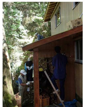
雨水槽への雨樋配管 薪小屋の屋根・外壁波トタンのペンキ塗り
