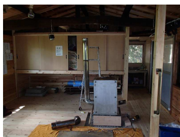
不動堂裏に積んだ薪 改造ストーブ組立 排煙煙突据付中
