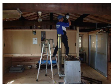
不動堂裏に積んだ薪 改造ストーブ組立 排煙煙突据付中
