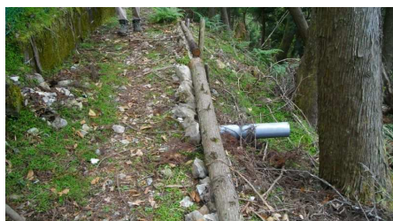
補給路谷側の補強
