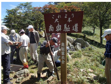
取替後の柱固め
