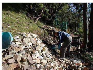
崩落石垣の基礎面まで掘る
