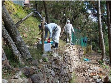
崩落箇所石積み完了
