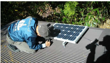
ソーラーパネルの設置
