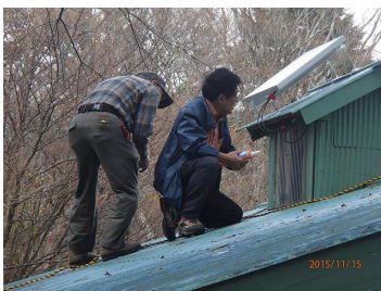
煙抜き屋根にパネル据付
