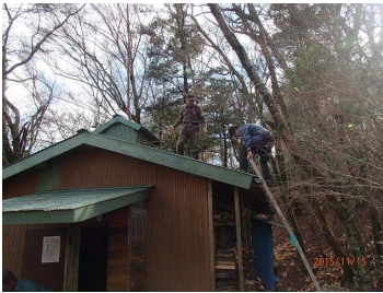
ソーラーパネル設置準備
