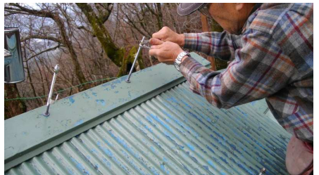
ソーラーパネルの取り付け準備
