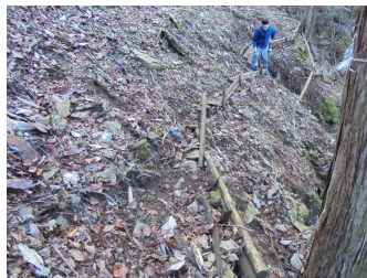
落ちた部材を引き上げ
