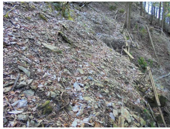
崩れの酷い箇所
