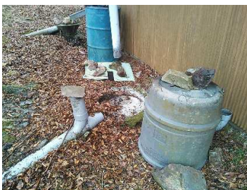
雨水貯槽裏返し
