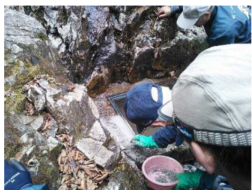
水場の水溜めのセメント補修
