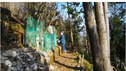
フェンスの補修
