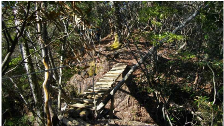
2013年架設の木橋
