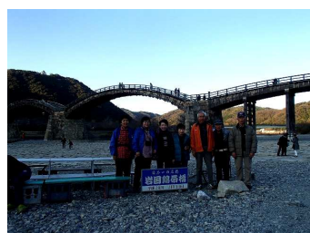
岩国市・錦帯橋
