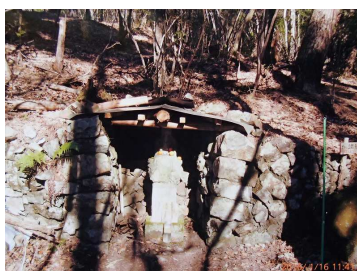
新規トタンで応急処置
