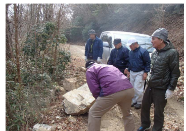
落石をバールで除ける
