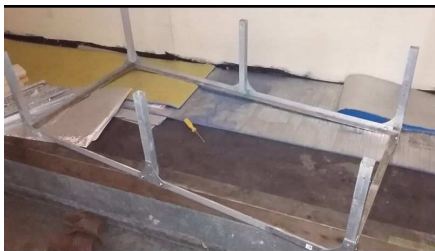
床材の梱包を解く アングルの組み立て ほぼ組みあがった脚部(塩川)
