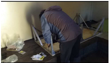
床材のネジ止め
