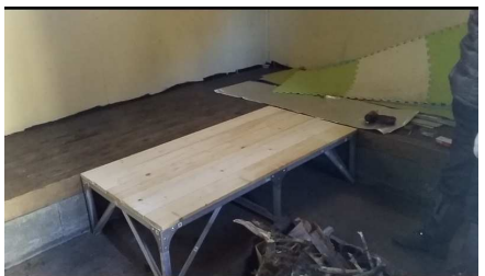
完成した増床部
