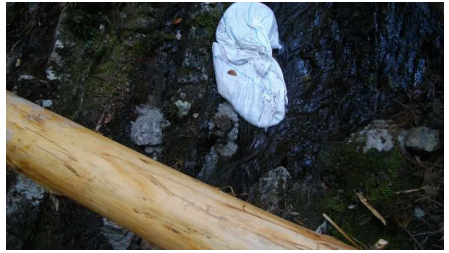
土嚢でせき止め
