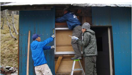
補強材取付け
