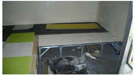
塗装した増床部
