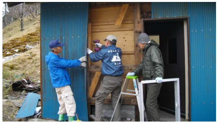
窓取付け準備
