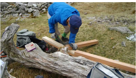
補強材の加工
