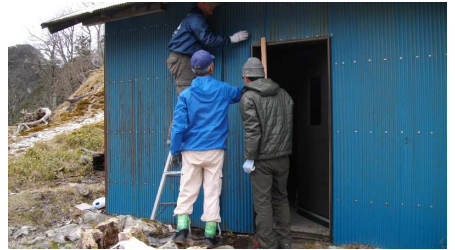
外壁を元に戻す
