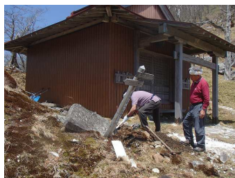
倒れた石碑・道標の復元作業
