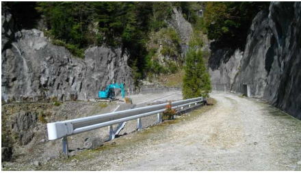
重機で整地されていた
