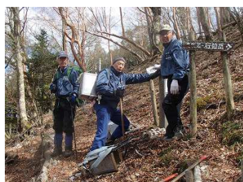
分岐下修復完了
