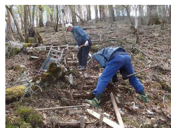
北面の段差修復
