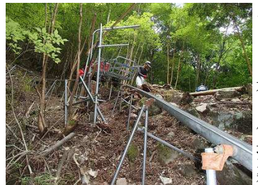
前回迄の小屋単管支柱
