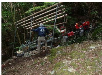
駐機小屋の支柱組立完了
