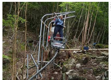
単管パイプに角材取付け
