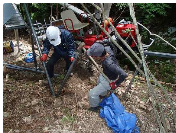
支柱固定のパイプ打込み
