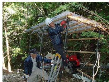
パイプ端切断の火花
