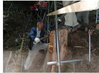
壁張り支障の木株ハツリ
