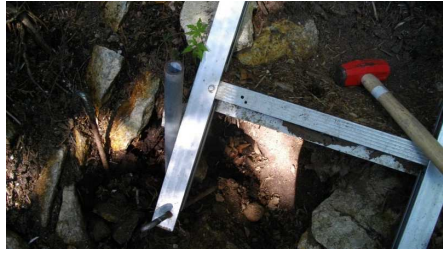
ガス管を打ち込む
