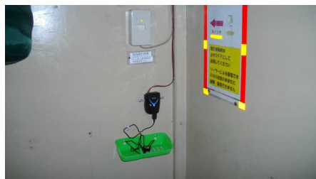
携帯充電器取付け
