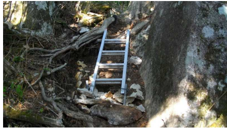
アルミ梯子補強完了
