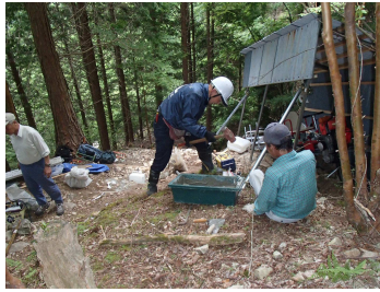
パイプにセメント詰
