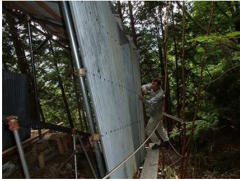
狭い足場上で傘釘打ち
