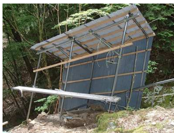
後側トタン壁完了
