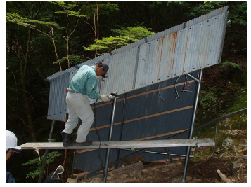
角材に沿って切断
