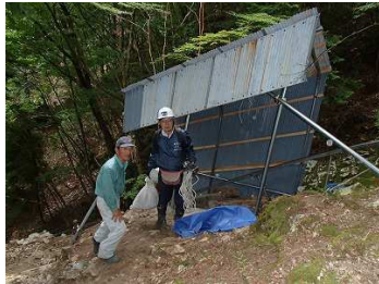
完成した駐機小屋
