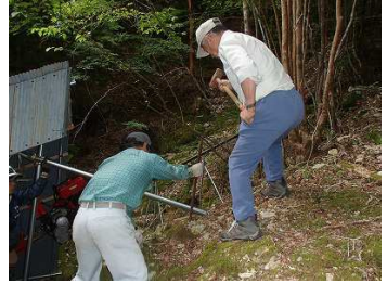
支え支柱用鉄筋打込み
