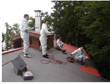
玄関側屋根下塗り完了
