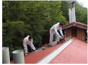
玄関側屋根下塗り完了
