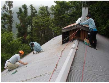
煙抜き・東側トタンの錆落し
