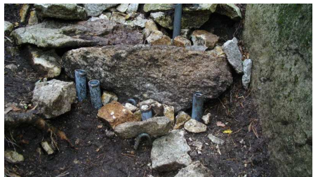
パイプ4本打ち込み
