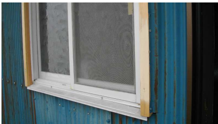
窓枠木材塗装
