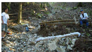
土のうを並べて完成
