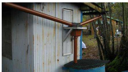
トイレ雨樋の交換には、先日栗原さんに寸法を測って頂いたのが役立ち、サイズ調整をすることなくピツタリと合い、スムーズに作業が行えた。50分で取換は完了。ドラム缶上の垂直部樋は接着せずに差し込んでいただけなので、ドラム缶の移動時にはすぐに外すことができる。
