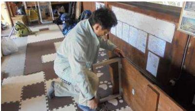
食事台の止め金具をステー金具に取替作業
