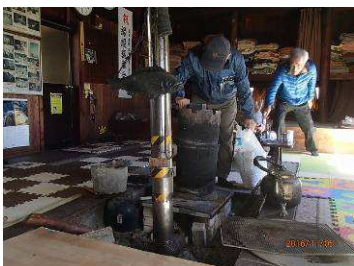
ストーブ改修中
