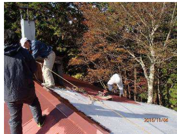
宿屋根塗装作業中
