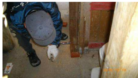
柱をボルト締付け
