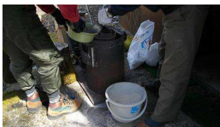
ストーブ断熱材の入れ替え
