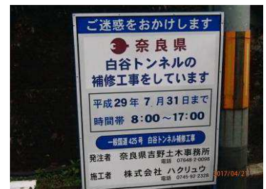
白谷トンネルの工事標識
