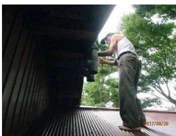
換気排煙筒の固定(玄関側)
