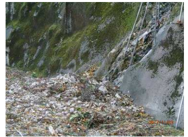
支谷流出土石で側溝埋まる
