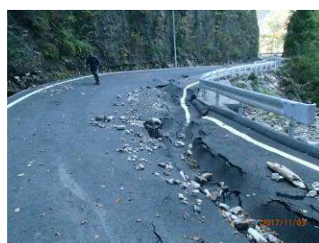
舗装面が凹凸・陥没により通行止め
