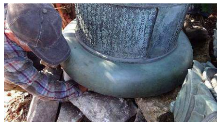
台座下の石積み積み直し 台座水平に石積み修正 据えた像をザイル固定
