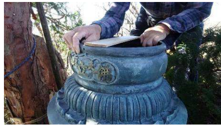
台座下の石積み積み直し 台座水平に石積み修正 据えた像をザイル固定
