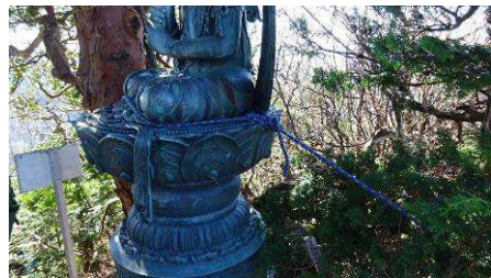
台座下の石積み積み直し 台座水平に石積み修正 据えた像をザイル固定
