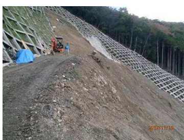
大崩落の復旧工事斜面
