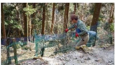
オオヤマレンゲと荘川桜(下)の獣除け金網補修
