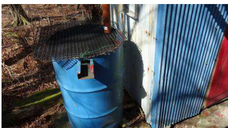
トイレ水洗用の雨水ドラム缶設置
