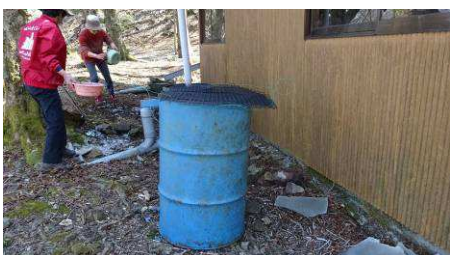
トイレ水洗用の雨水ドラム缶設置
