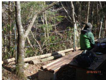
くい丸に木杭固定
