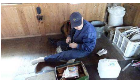
バッテリー交換作業
