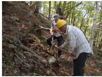
北面段差の補修
