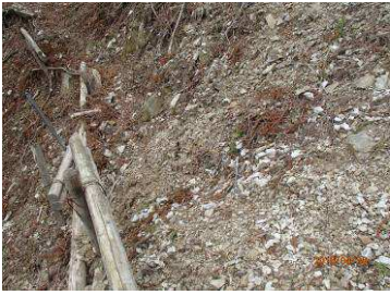
旧通信道の横棧木流失箇所の補修作業
