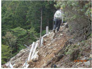
No24鉄塔前の道補修
