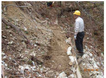
補修作業後の道
