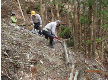
旧通信道の横棧木流失箇所の補修作業
