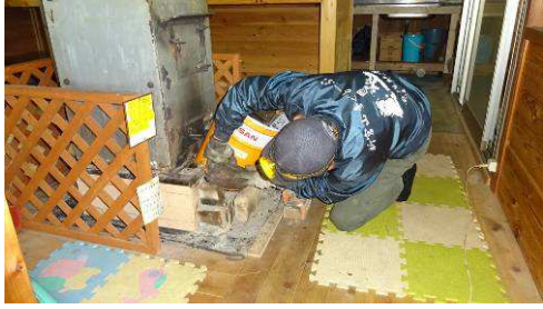
接続部に耐火モルタル
