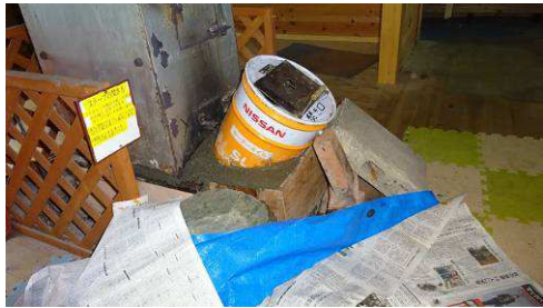
ストーブ焚口改修後
